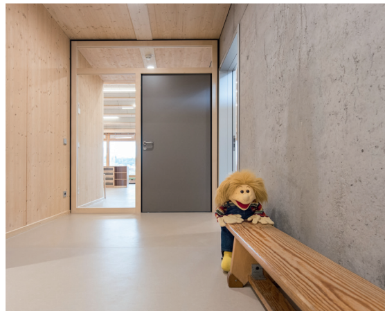
BU 10: Die Fingerschutztür mit der Zargenvariante HFI bietet durch ein formreduziertes Falzprofil nahezu ideale Voraussetzungen für eine Verbindung von Holz- und Glaswänden.
