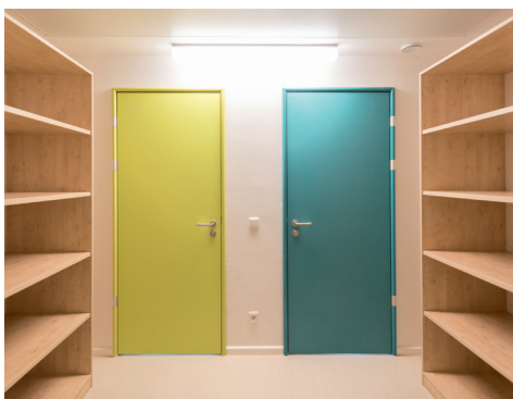
BU 11: Gestaltungskonzept mit Orientierungsfunktion: Fingerschutztüren gestaltet im Farbleitsystem einer Kindertagesstätte.
