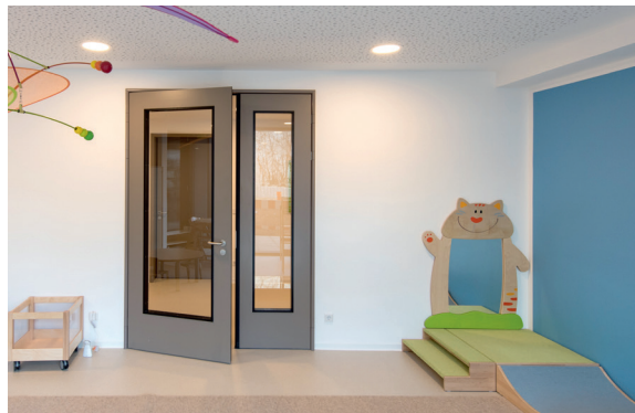
BU 8: Für den Umbau gibt es Renovierzargen, die einfach über vorhandene Stahlzargen montiert werden können. Nachträgliche Beschläge oder Rollos sind nicht erforderlich.
