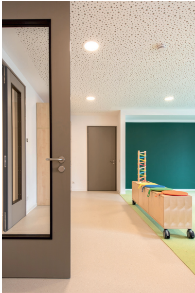
BU 5: Die Küffner-Fingerschutztüren sind barrierefrei zertifiziert und speziell für den Einsatz in Kindertagesstätten geprüft.
